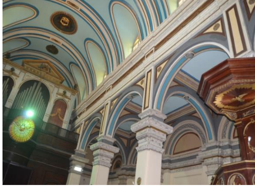
لوحة (9) توضح العقود النصف دائرية المحمول عليها سقف الكنيسة المنكسر وفي المنتصف فتحة نافذة دائرية يتوسطها صليب
